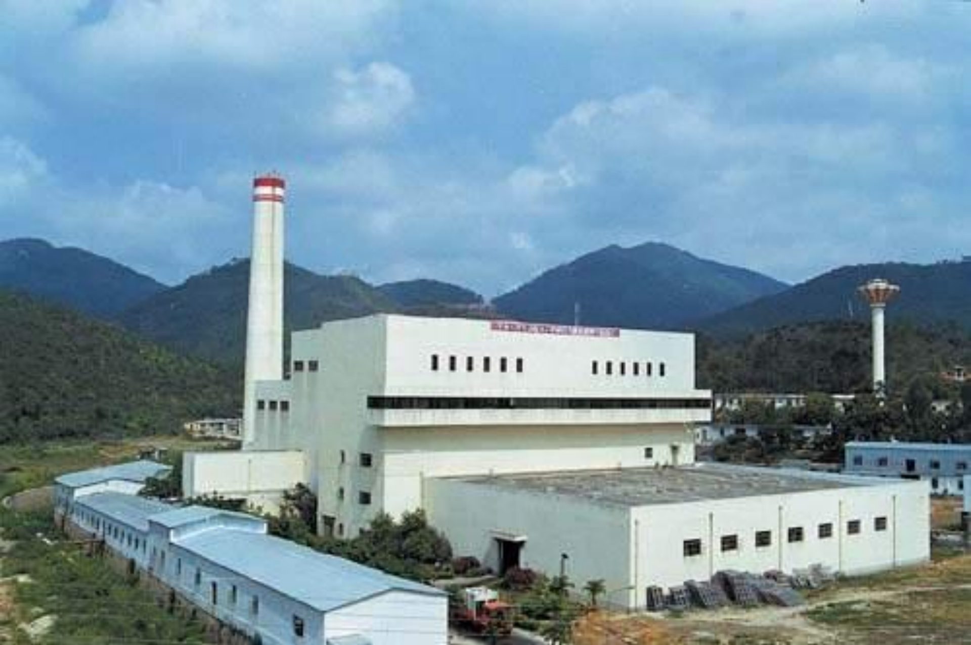
深圳垃圾发电厂
